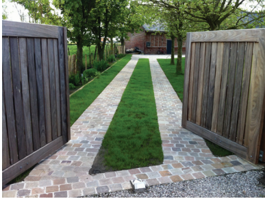
Bandes de roulement pavées ou béton balayé
