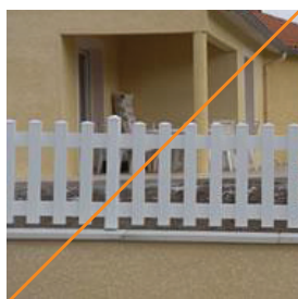
Muret maçonné réhaussé de bardage PVC
