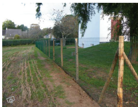
Grillage «à moutons» sur poteaux châtaigniers - hauteur max 1,50m
