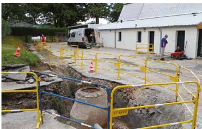
Le SIAEP en a profité pour supprimer le réseau en amiante-ciment.
